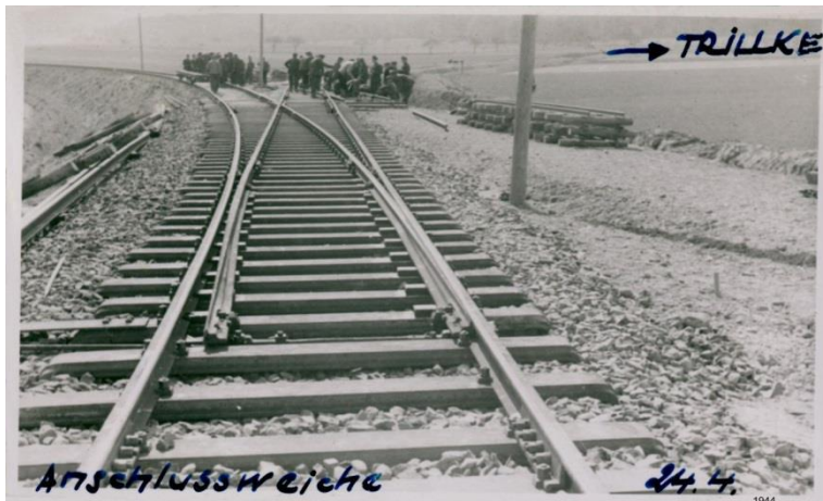
Der neue Gleisanschluss verband die Trillke-Werke mit Schienen, die zum Hildesheimer Hauptbahnhof führten. Boscharchiv Hildesheim, Album Gleisanschluss2, Anschlußweiche Trillke1944
